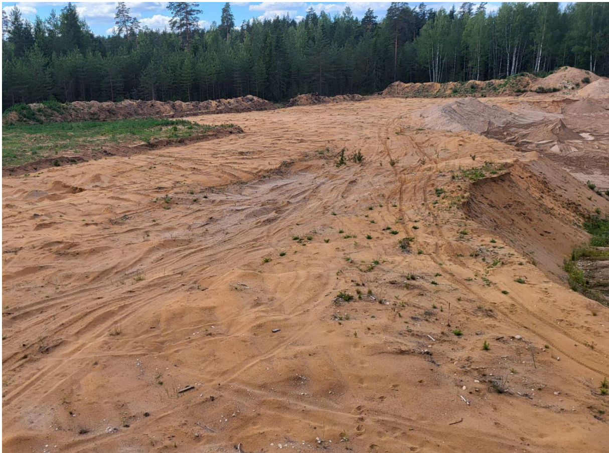
Foto 2. Liiva kaevandamiseks ettevalmistatud ala – katend on järk-järgult kooritud ja ladustatud puistangutesse. Pildistas Ranek Rohtla.
